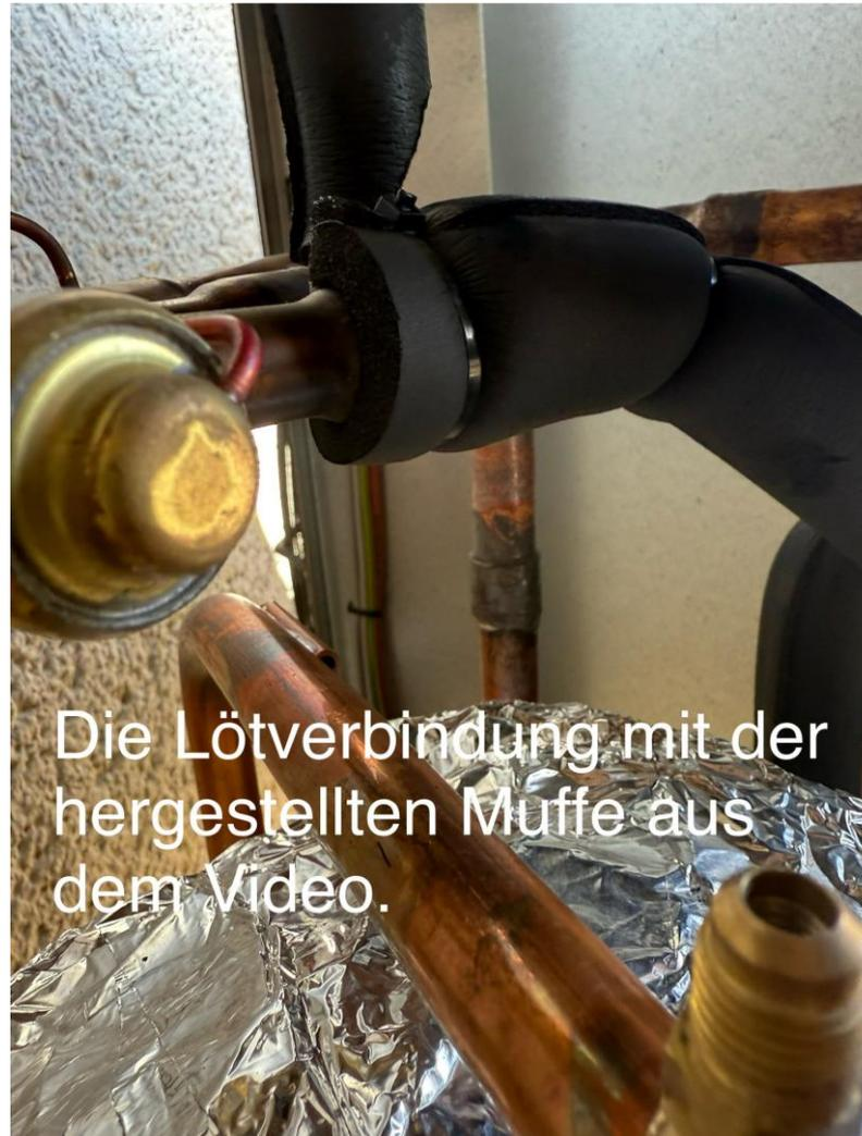
Die Lötverbindung mit der
